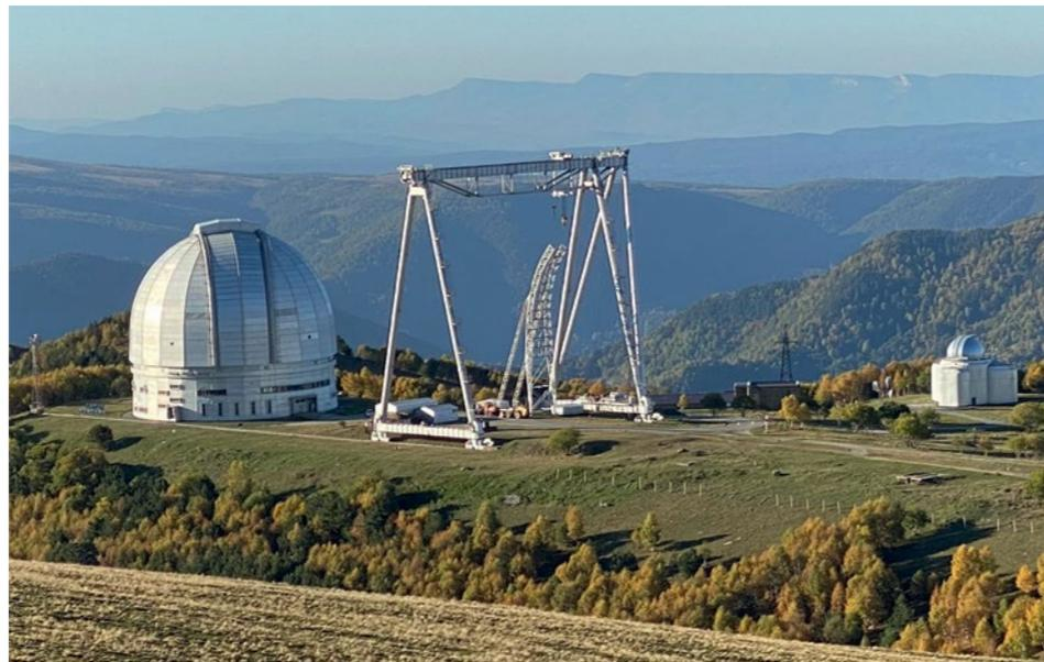
которых происходит вокруг оси под наклоном, повторяя движение звезд по небосводу. Азимутальная монтировка была выбрана из-за тяжести зеркала телескопа — без оправы оно весит 42 т. Масса подвижной части инструмента составляет 650 т, а общая масса телескопа вместе с башней превышает 850 т.
