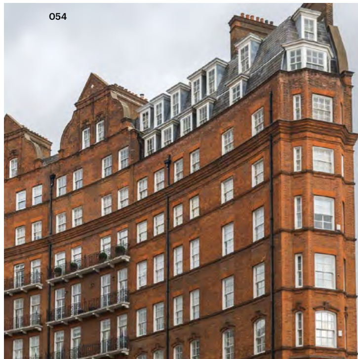
Многоквартирные дома Albert Hall Mansions в Кенсингтоне построены в 1870-х, небоскребы по меркам того времени
