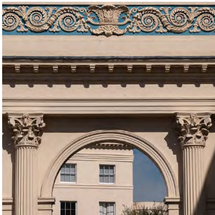
Chester Terrace возле Риджентс-парка — отличный пример отделки фасада штукатуркой по моде начала XIX века
